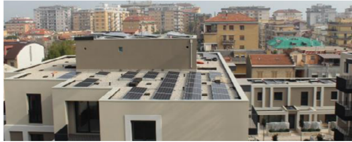
Lecce POSTE ITALIANE 25kW PV Plant
